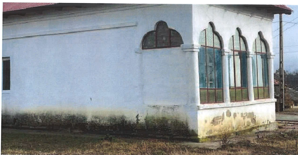
- soclul constructiei afectat de infiltratii rezultate prin stropire si ridicare prin capilaritate-
