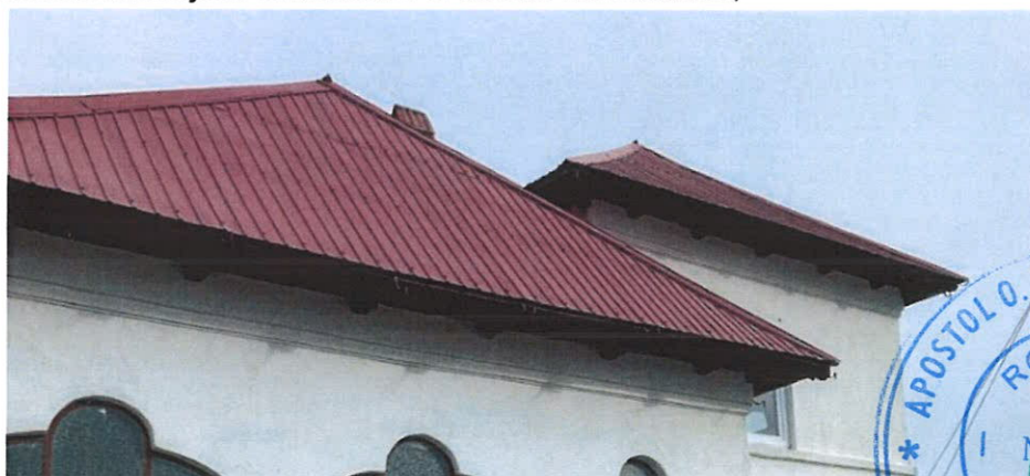
- sistem de preluare ape pluviale inexistent-
